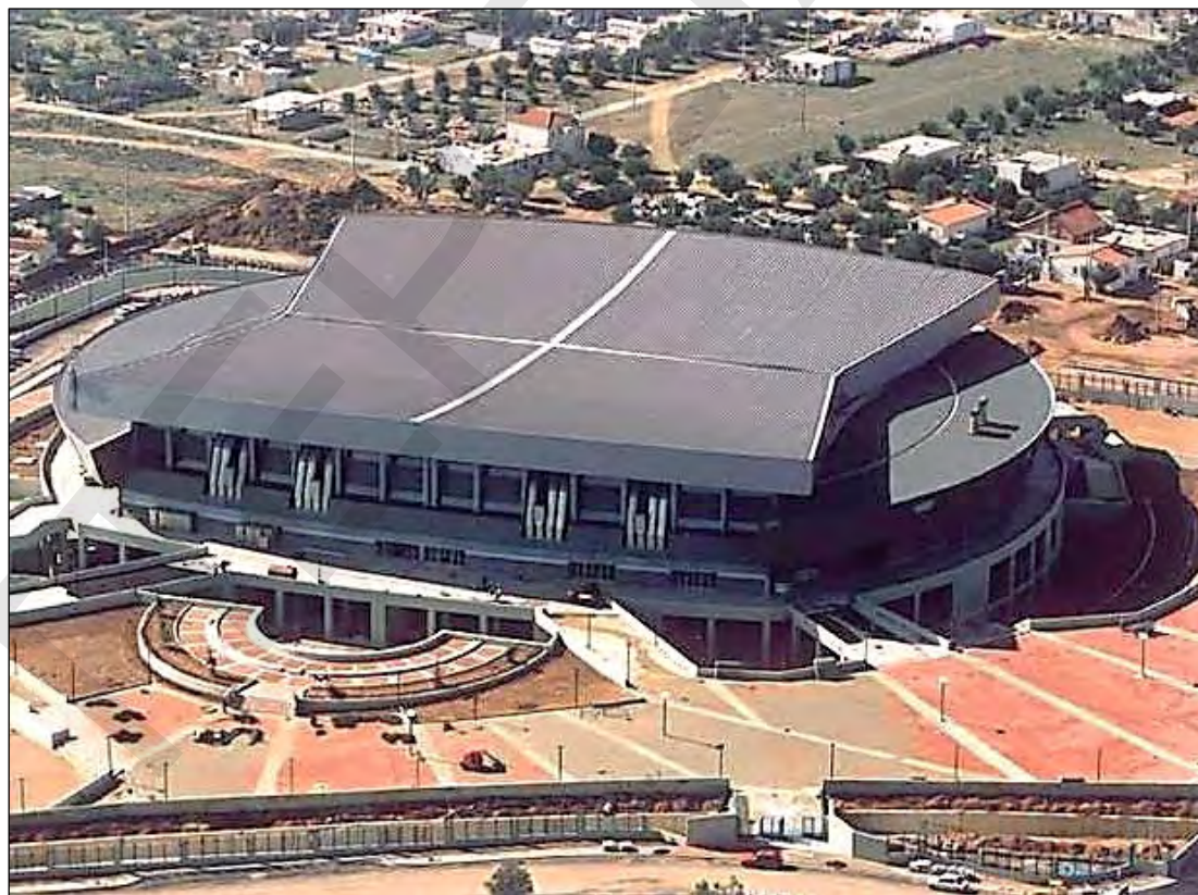
Το Ολυμπιακό Στάδιο των Άνω Λιοσίων εξωτερικά
